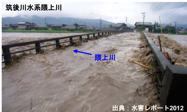
平成24年7月に九州地方で発生した豪雨時の橋梁部における堰上げ状況
